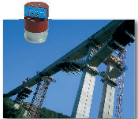
Monitoring of bridges Überwachung von Brücken
